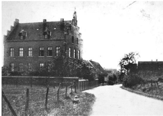
Das alte Krankenhaus an der Schöppinger Straße
