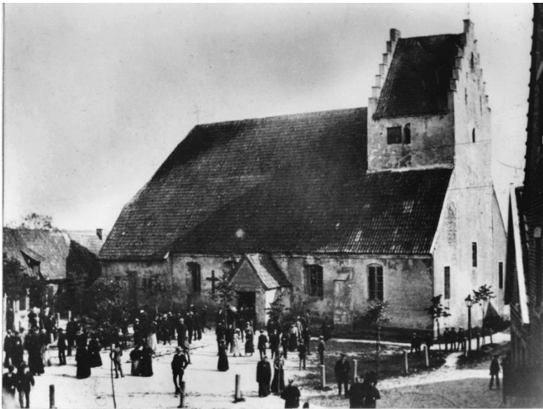
Die alte Pfarrkirche (Nordseite)
